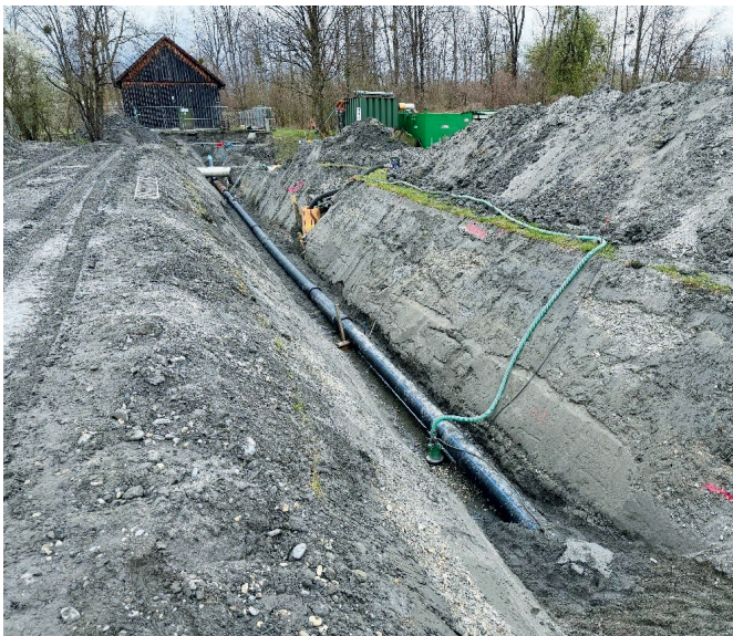
Im vorderen Bereich der knapp drei Meter tiefe Graben für den Einbau der neuen Wasserleitung Im Hintergrund das Grundwasserpumpwerk Oberau
