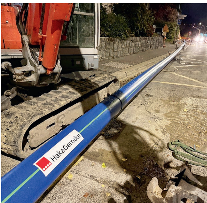
Ausgelegte, rund 300 Meter lange Rohrstange unmittelbar vor dem Einzug unter die Fallgass
