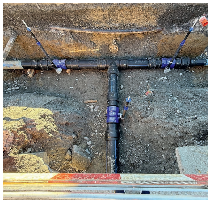
Knotenpunkt Fallgass in Richtung Reservoir Obergut vor dem Einfüllen
