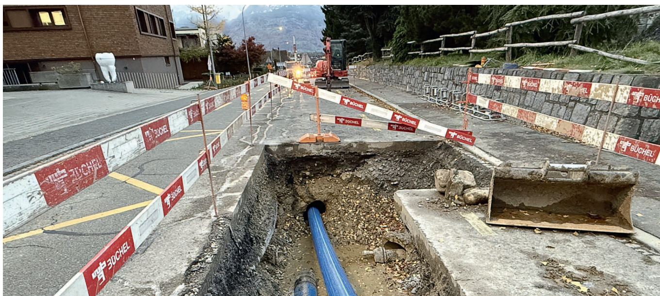
Nach dem Einzug des 300 Meter langen Rohres und vor dem Zusammenschluss beim Knotenpunkt Fallsgass in Richtung Reservoir Obergut
