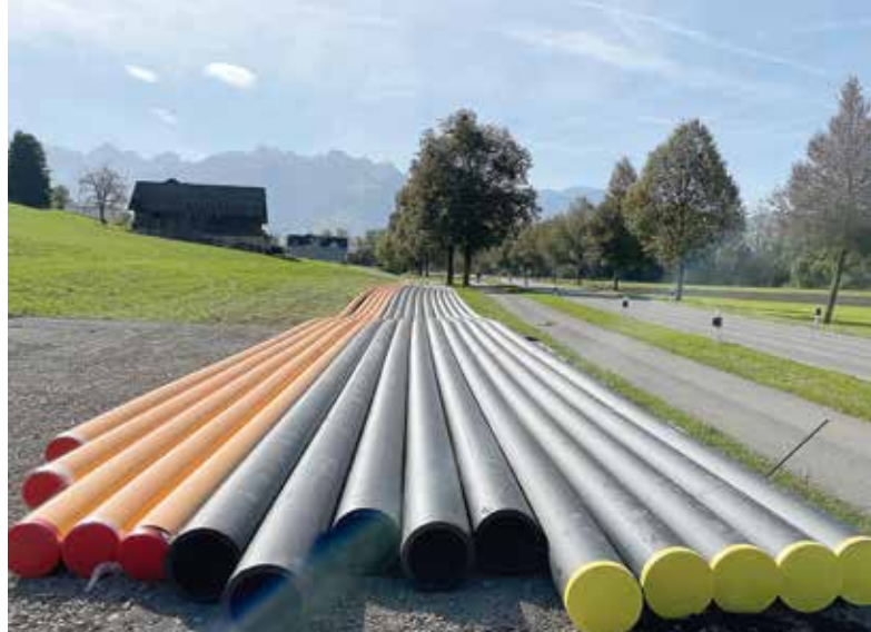
Gemeinsamer Werkleitungsausbau von Ruggell bis nach Gamprin / Vorbereite Rohre für den Leitungsausbau (Gas, Abwasser und Wasserleitung)
