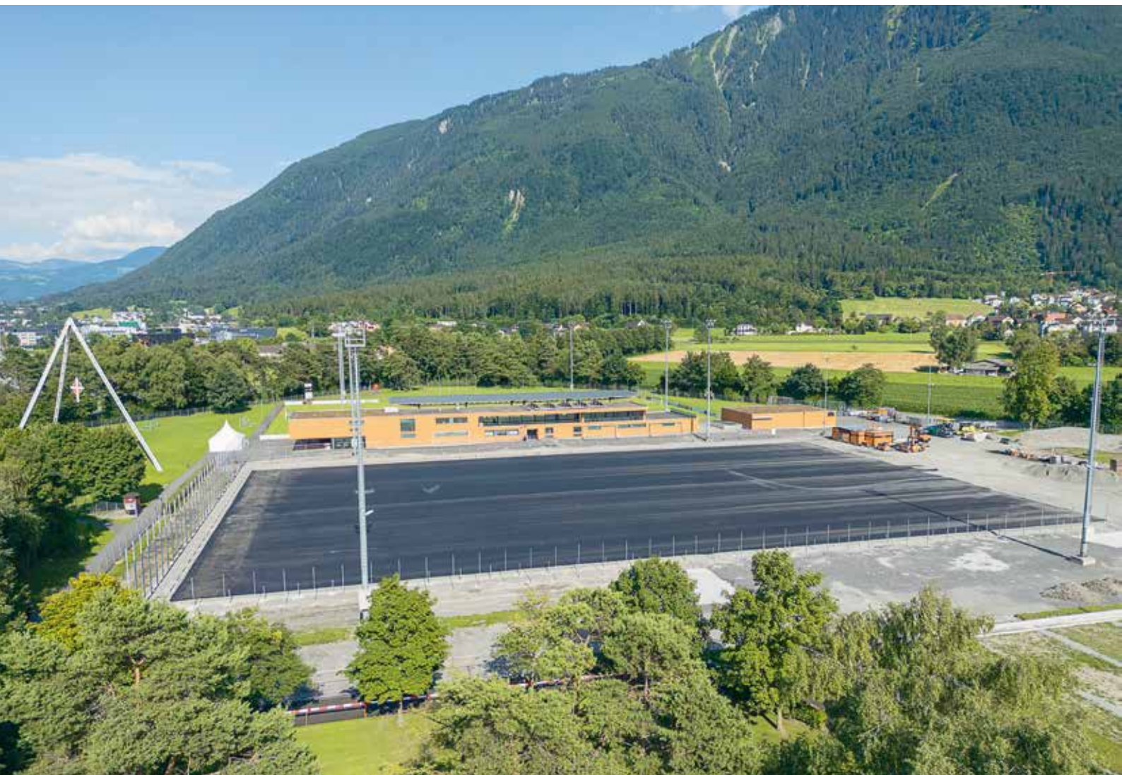
Kunstrasenplatz im Entstehen (schwarzer Zwischenbelag)
