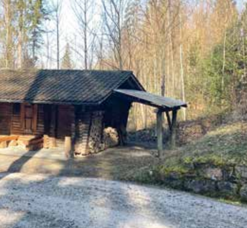
Vorher: mit Blechdach und verschlammtem Vorplatz
