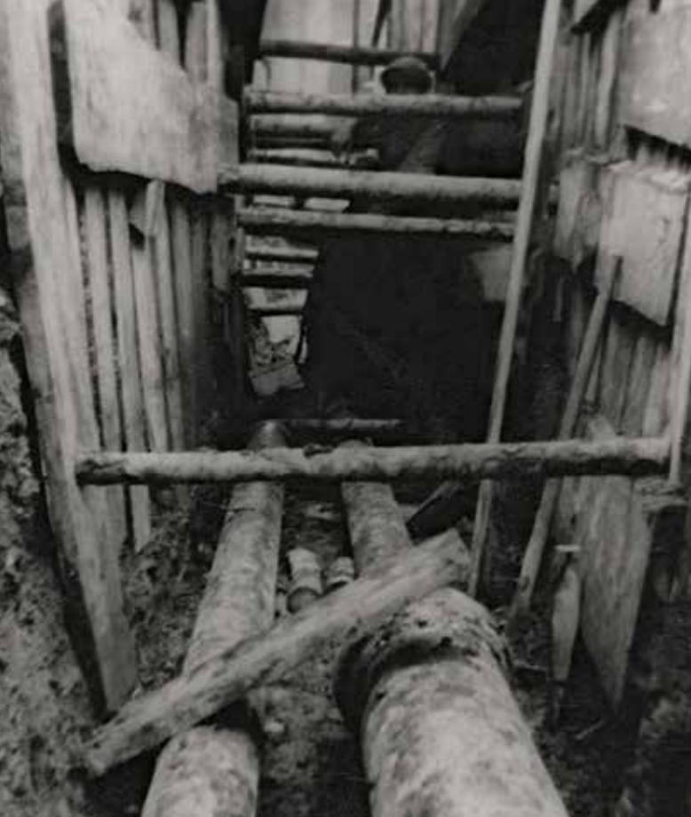
Die beiden Hauptleitungen im Graben unter dem Bahnkörper bei Km 9.644 der Strecke Feldkirch – Buchs, aufgenommen im Sommer 1932. Vorne rechts das 250 mm Überschub-Schutzrohr mit der 150 mm Hauptwasserleitung im Hintergrund. Links das 150 mm Schutzrohr. Im Hintergrund ein Bauarbeiter.
