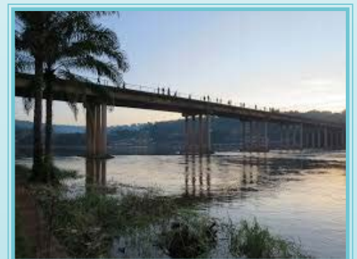
Die neue Brücke über den Kwilu.
