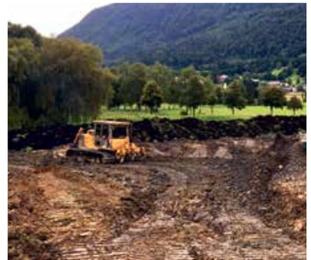
*Der angelieferte Erdaushub wird laufend gemäss Geländemodell eingebaut und planiert.*
