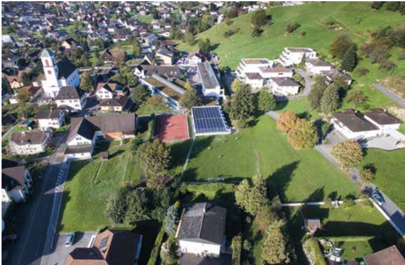
Blick auf das Schulareal in Mauren. Das Erweiterungsprojekt sieht vor, dass die alte Einzelturnhalle (mit blauer Photovoltaikanlage auf dem Dach) durch eine neue Doppelturnhalle ersetzt wird und zugleich die Räumlichkeiten für fünf Kindergartenklassen realisiert werden. Ausserdem ist eine zusätzliche Tiefgarage geplant.
