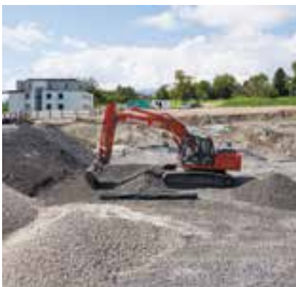
Aushubarbeiten im vollen Gange
