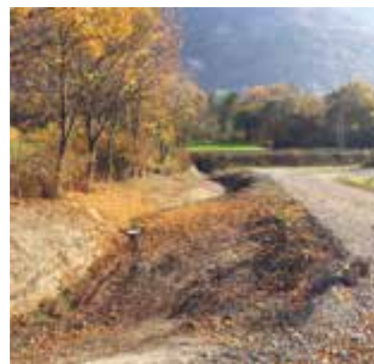
Der bisher kleine Industriegraben in der Arbeitszone wird um rund 10 Meter ausgeweitet.
