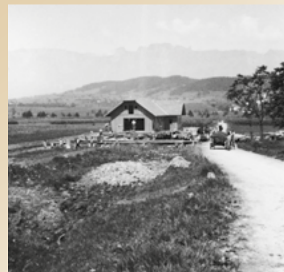
Die Gemeindegäge Mauren bei Inbetriebnahme im Jahr 1934.
