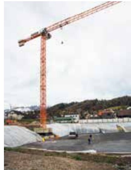
Baumeister zu Beginn Rohbau
