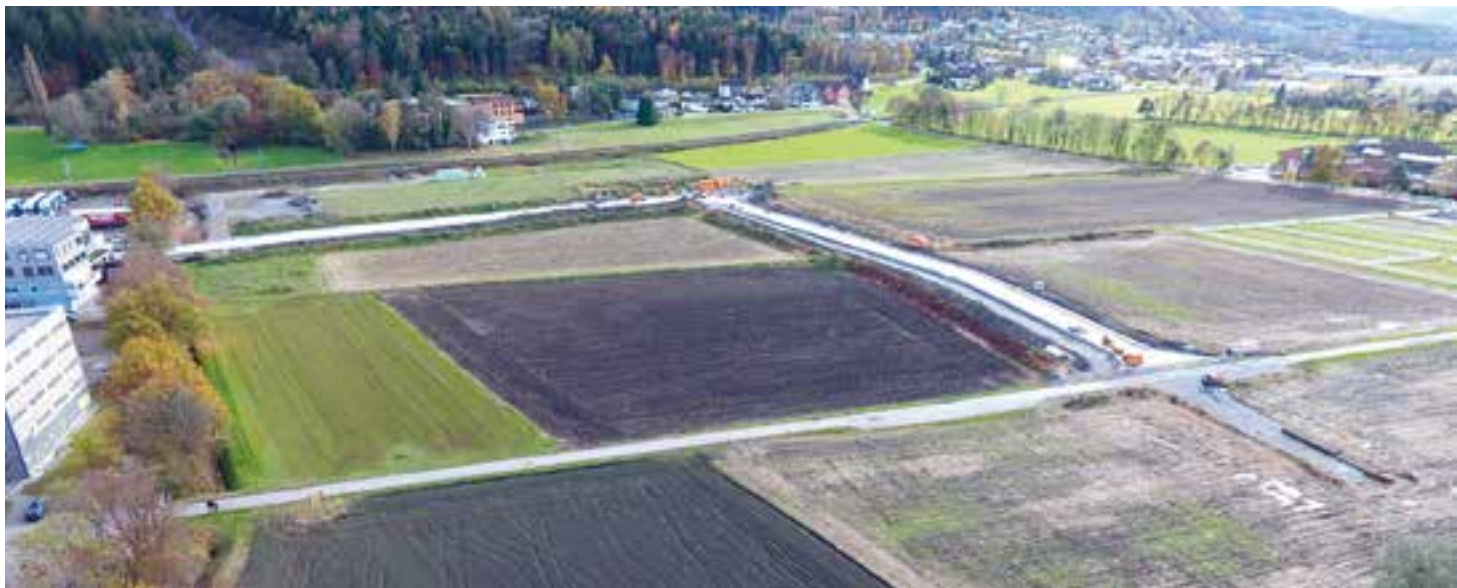
Diese Aufnahme zeigt den Stand der Bauarbeiten zur Erschliessung der erweiterten Arbeitszone in der ersten Novemberhälfte 2016.
