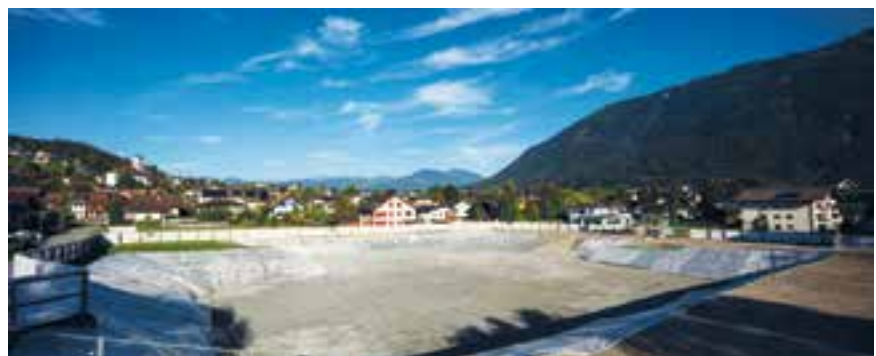
Baugrube fertig gestellt – Panorama
