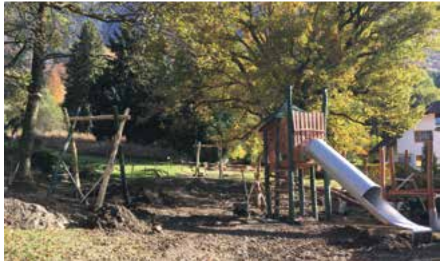
Impression von den Erneuerungsarbeiten auf dem schön gelegenen Waldspielplatz.
