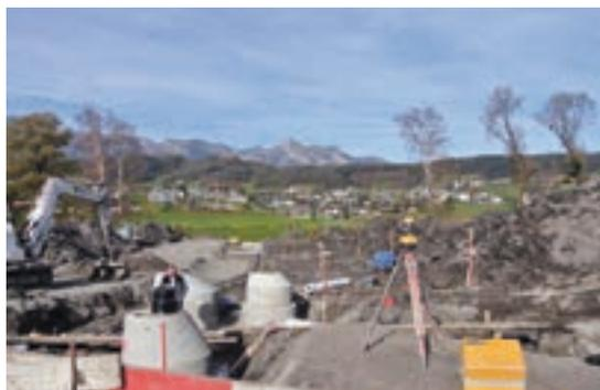
Der Baubeginn erfolgte aufgrund des Werkleitungsbaus am tiefsten Punkt, also im Anschlussbereich zum Hauptsammelkanal.
