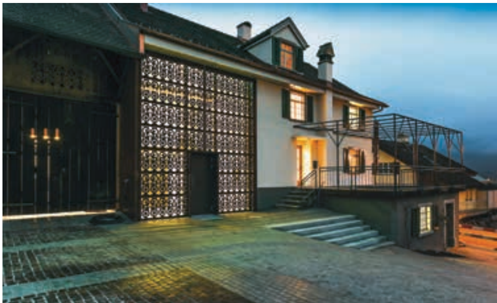
Aussenansicht des neuen Kulturhauses Rössle
