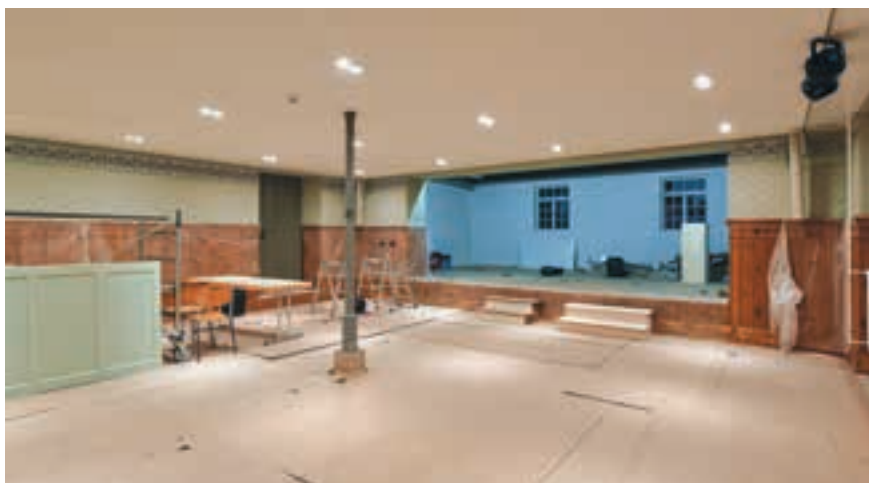
Innenaufnahme vom Saal mit Bühne kurz vor der Fertigstellung
