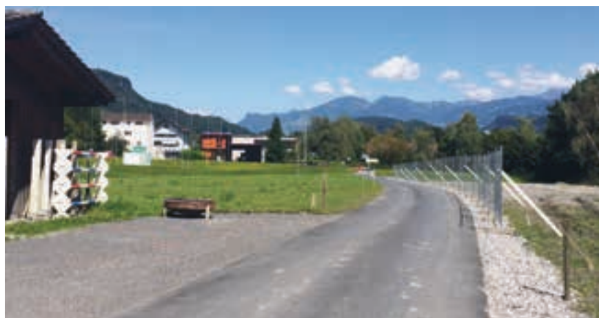
Die Deponie-Zufahrtsstrasse wurde vollständig auf öffentlichen Grund entlang der Siedlungsgrenze umgelegt.
