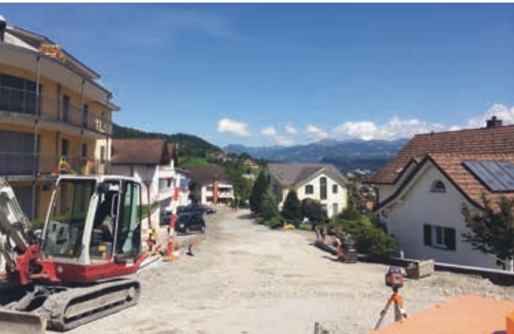
Die Totalsanierung der Strasse Obergut ist weit fortgeschritten.
