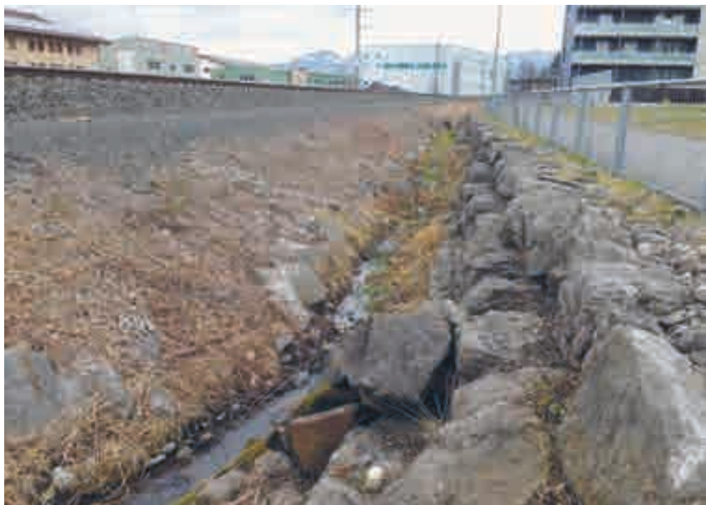
Gewässer als Vorfluter für Regenwasser aus der Siedlung
