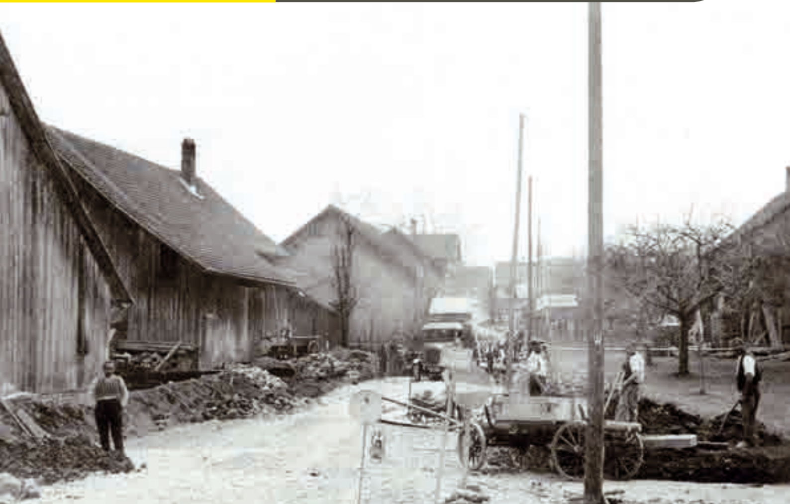
Verbreiterung der Dorfstrasse anfangs der Dreissiger-Jahre beim Bau der ersten Wasserleitung. Ursprünglich wurde der Karrenweg als «Neusträssle» bezeichnet.
