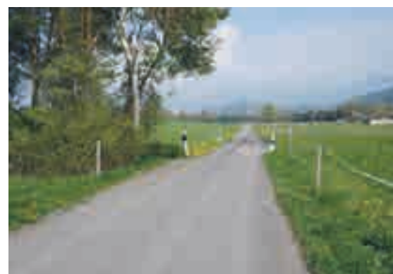
Verlegung und Sanierung Langmahdstrasse
