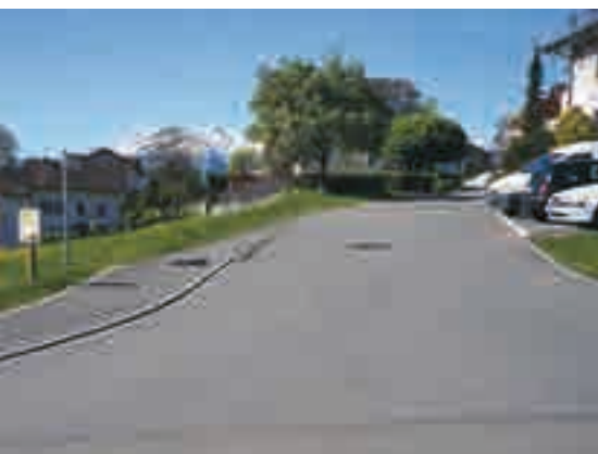
Sanierung Strasse «Obergut»
