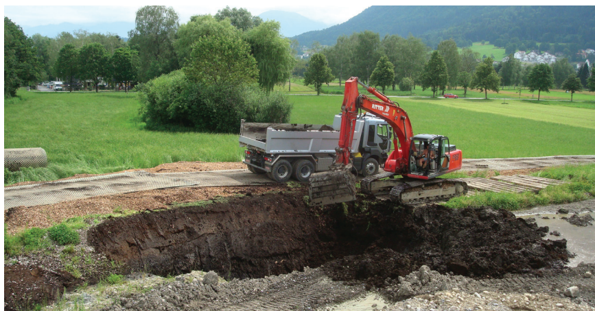
Vor dem Einbau des Erdaushubs wird der Torfboden ausgehoben.
