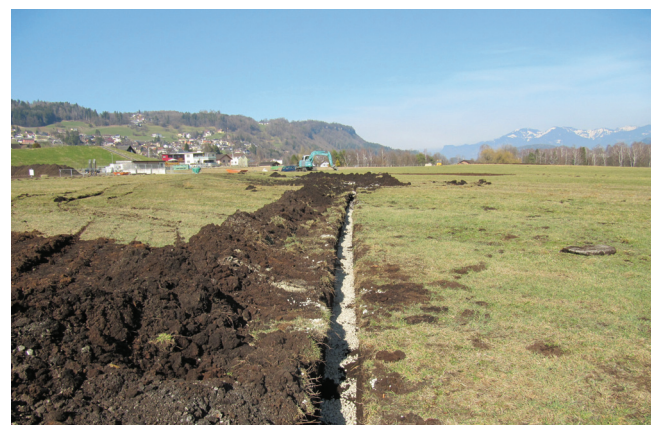
Mit der Installation von Entwässerungsleitungen wird die Entwässerung des Deponiekörpers unterstützt.
