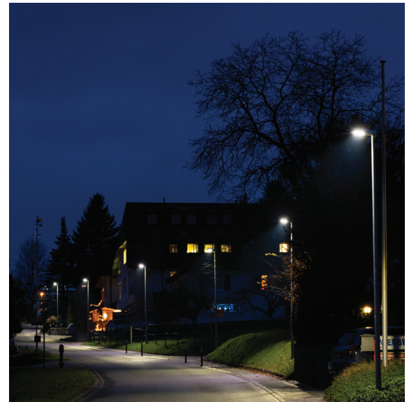
LED-Strassenbeleuchtung bei der Fürst-Franz-Josef-Strasse
