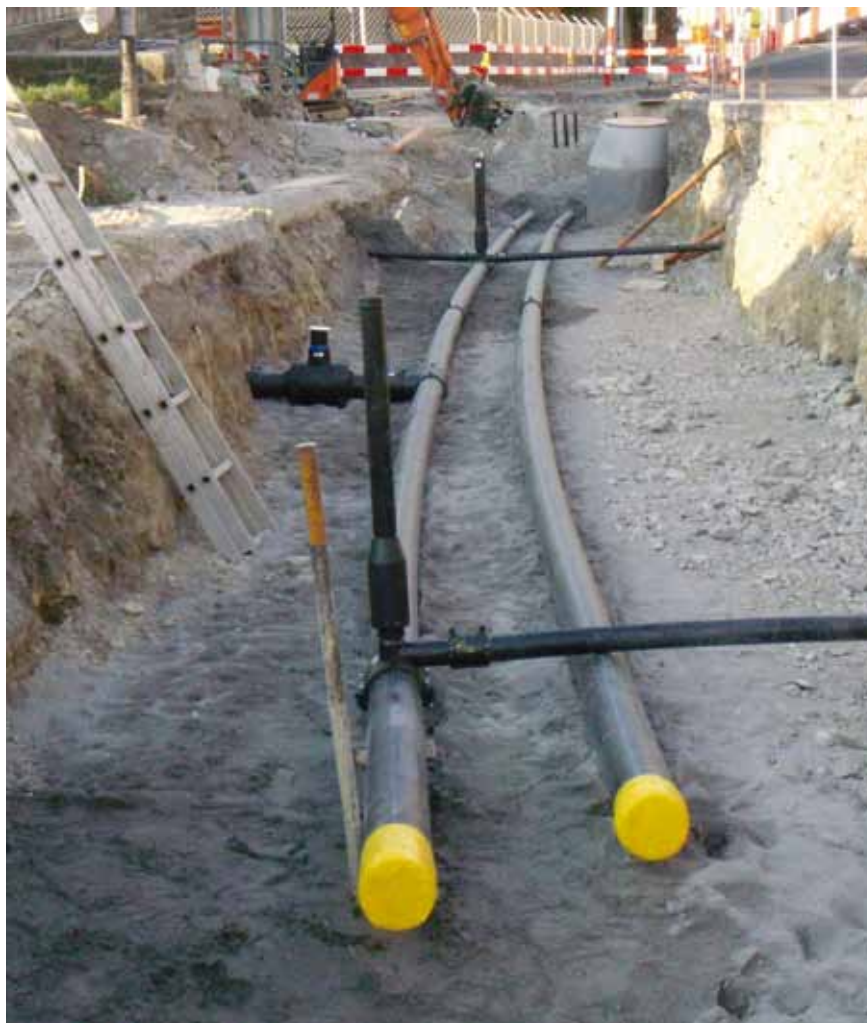
Erneuerung der Wasserleitung im Zuge der Sanierung der Strasse Kruppenacker in Mauren.
