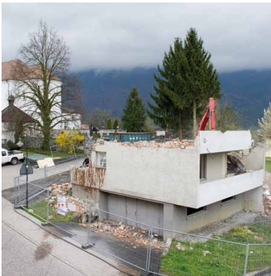
Abbruch der Liegenschaft Matt Mitte April
