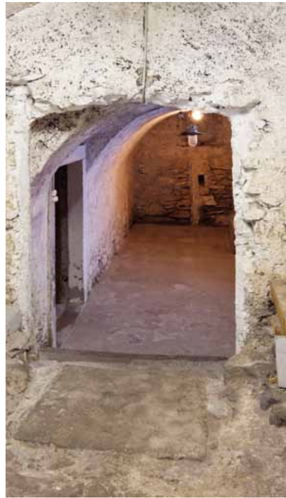
Rustikal gewölbte Kellerräume.
