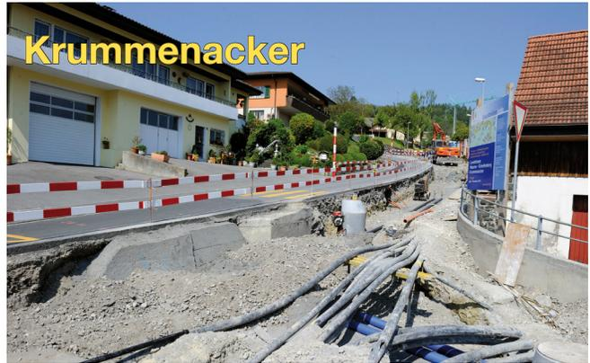
Bauherr dieser Strassensanierung «Krummenacker» ist das Land (Tiefbauamt), währenddem die Gemeinde für die Kanalisation sowie für die Beleuchtung zuständig ist. Neben dem Einbau einer Sauberwasserleitung auf der Länge von 150 m wird auch eine neue Trottoirverbindung erstellt.
