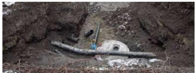
**Verlegung Kanalisationsleitung IGZ Schaanwald:** Im Zuge des geplanten Gebäudes auf der Parzelle 1616 wurde die bestehende Schmutzwasserleitung, welche das Gebiet «In den Teilen» in Schaanwald entwässert, verlegt.
