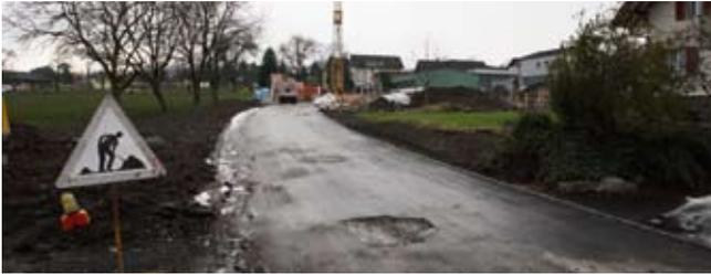
**Verlängerung Strasse Gänsenbach, Mauren:** Das neue Strassenstück mit einer Länge von ca. 65 m und einer Breite von 5 m dient zur Erschliessung der Baugrundstücke sowie des Projektes «Älter werden in Mauren».
