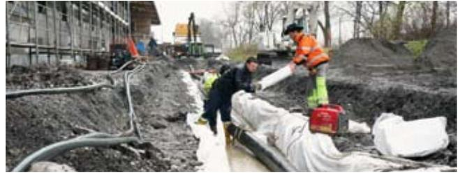
**Fernwärmeleitung IGZ Schaanwald:** Das restliche Teilstück der Fernwärmeleitung zwischen dem Mehrzweckgebäude und der Parzelle Nr. 1598 ermöglicht den wärmetechnischen Anschluss aller Gebäude nördlich der Industriestrasse Schaanwald.
