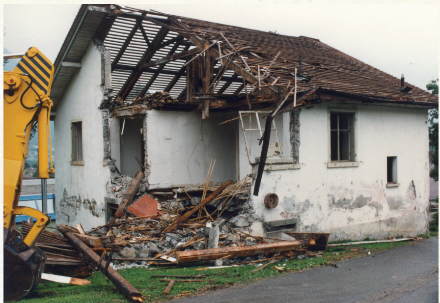
Abbruch der Kaplanei am 19./20. Juli 1994
