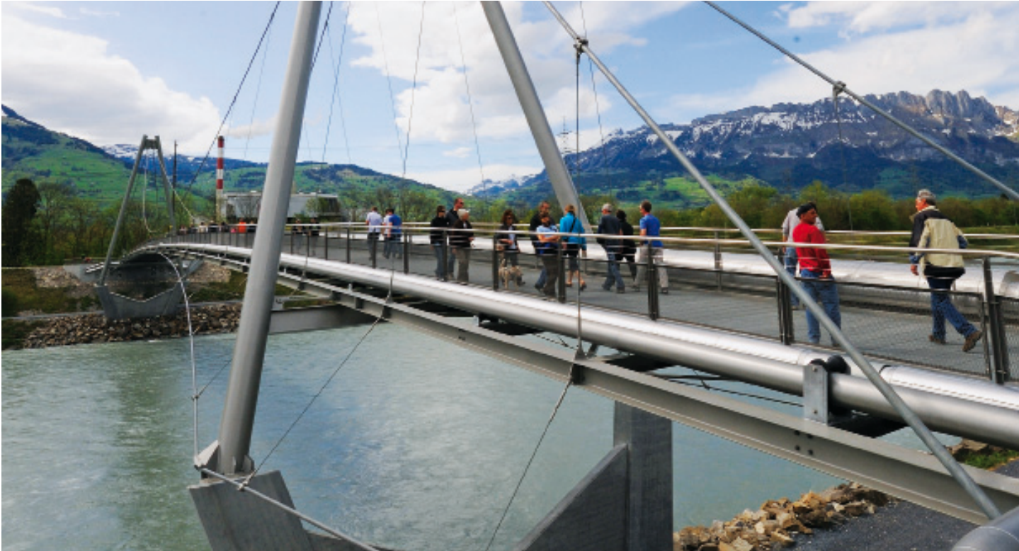
Energiebrücke mit Dampfleitungen nördlich der Rheinbrücke Schaan-Buchs
