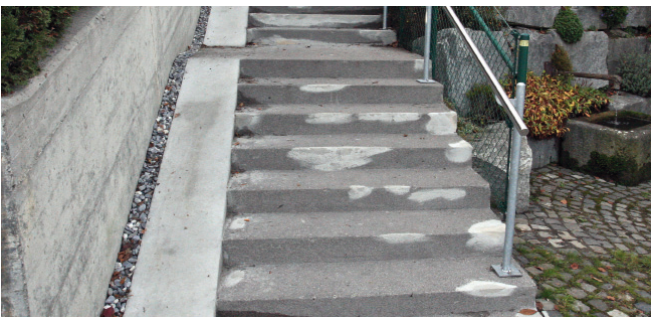
Treppensanierung beim Felbenweg
