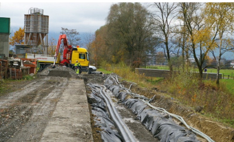
Neubau Fernwärmeleitung entlang der Esche
