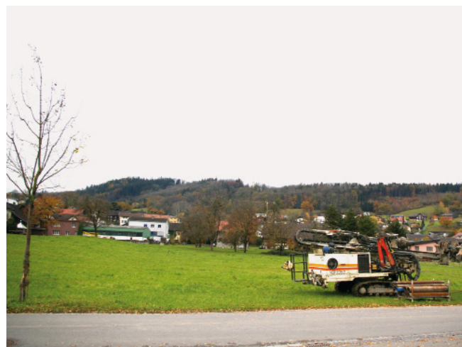
Baugrunduntersuchungen im Gebiet Lacha
