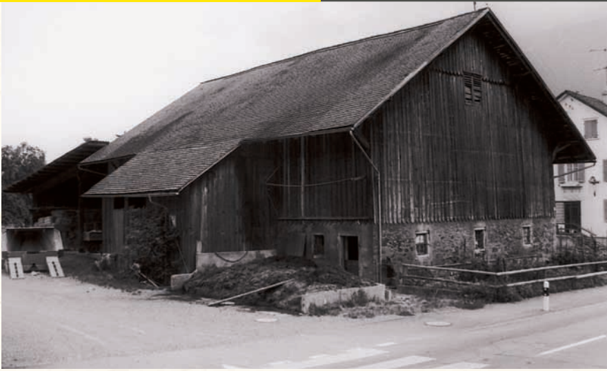
Der Bürgerheimstall brannte 1896 ab und wurde wieder aufgebaut.
