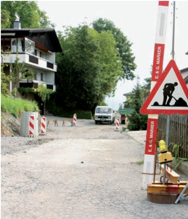
Sanierung Klosterwingertstrasse, Mauren
