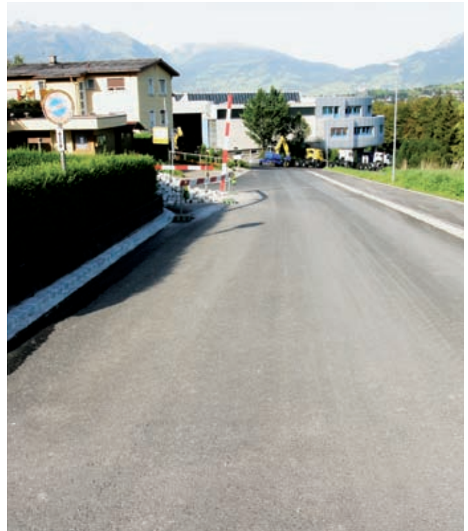
Sanierung Heiligwiesstrasse, Schaanwald
