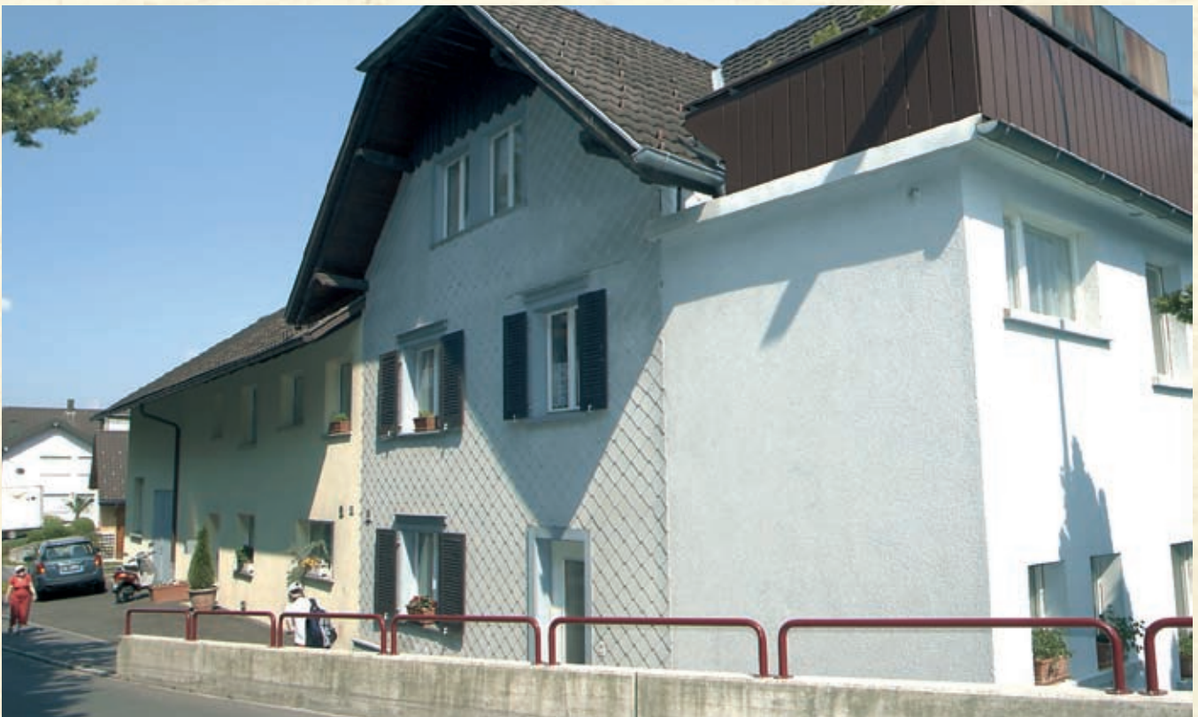
Ehemaliges Gasthaus «Linde» an der Binzastrasse
