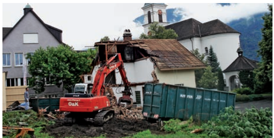
Der Abbruch des «Brunhilde Marxer-Ritter-Hauses» war mit Wehmut begleitet. Unser Bild gibt einen kleinen Einblick in die Abbruchtätigkeit des Baubaggers.
