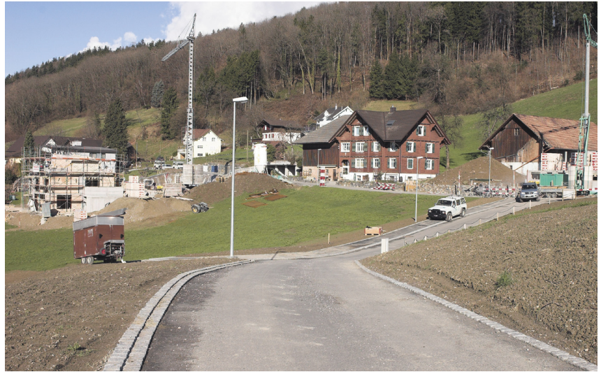
Die neue Strasse Wieshang ist in weiten Teilen bereits fertig gestellt. Die Arbeiten am Wendehammer sollen bis spätestens Ende August beendet sein.
