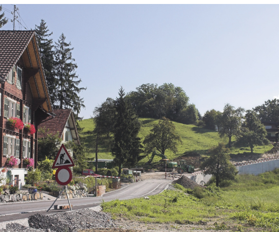
Strassenkorrektur «Auf Berg», 3. Etappe, Teil 1
