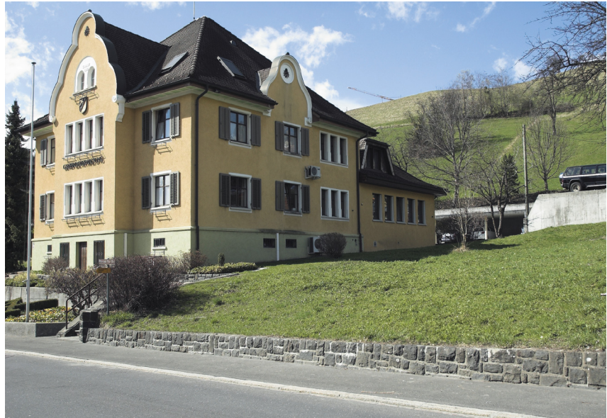
Auf dieser Gemeindeparzelle Nr. 330 entsteht der Erweiterungsbau der Gemeindeverwaltung.
