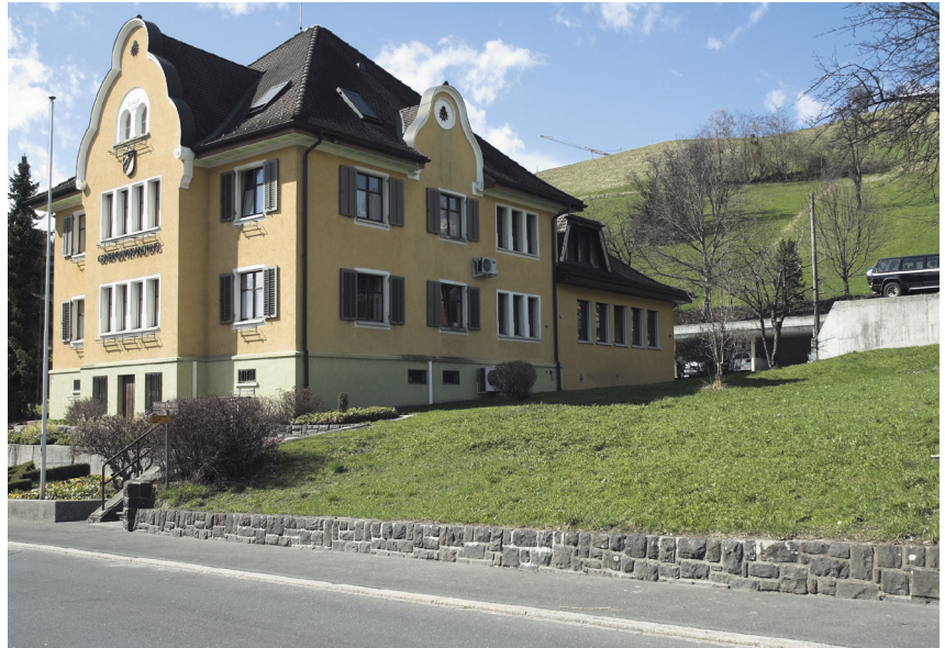
Auf dieser Gemeindeparzelle Nr. 330 entsteht der Erweiterungsbau der Gemeindeverwaltung.
