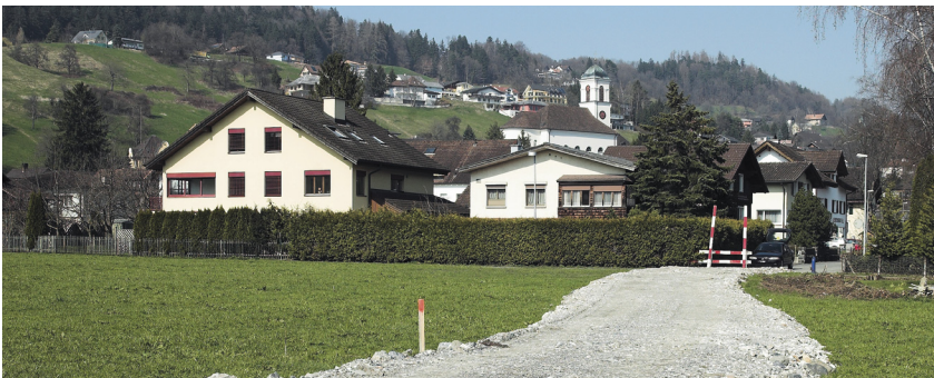
Die Erweiterung der Lachenstrasse
