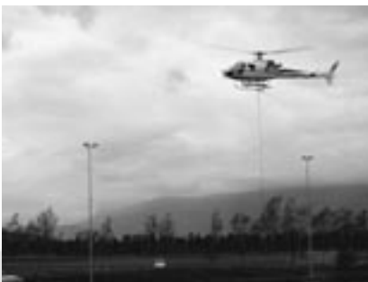
Mastensetzung per Helikopter.
