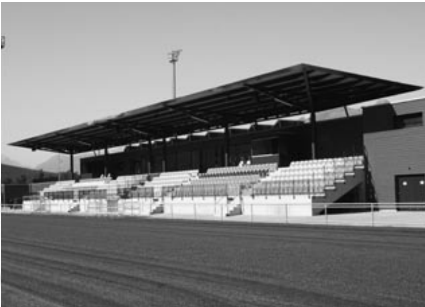
Blick auf die neu erstellte Tribünenanlage mit gedeckten Sitzplätzen.
