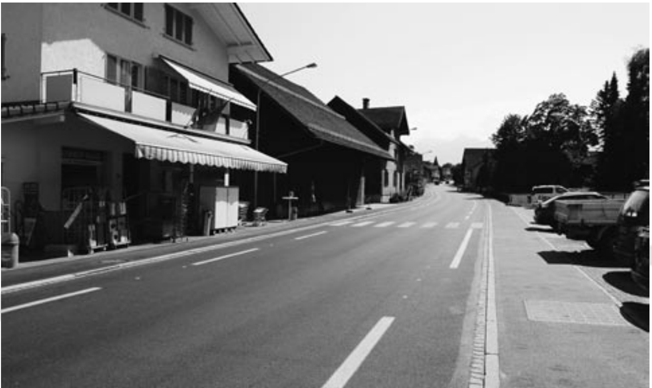
Die Peter-Kaiser-Strasse in Mauren ist der erste Strassenraum Liechtensteins, in dem eine so genannte Kernfahrbahn verwirklicht wurde. Diese wird schon bald bis zum Presta-Kreisel in Eschen erweitert.
