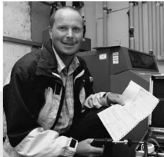
Manfred Kaiser bei der Rauchgaskontrolle einer Heizungsanlage.
