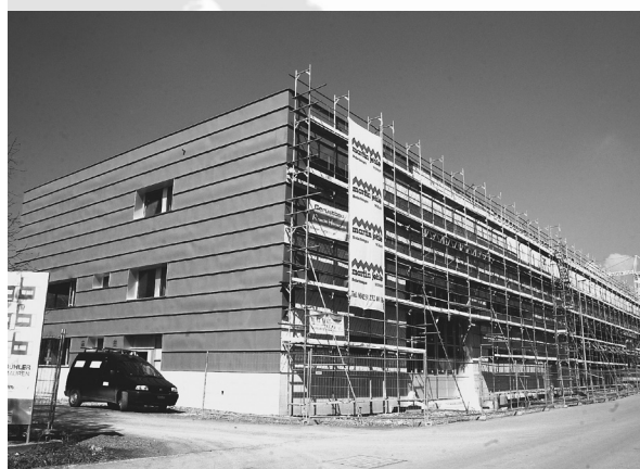
Die Aufnahme entstand vor wenigen Tagen. Der Bau ist strassenseitig noch nicht vom Gerüst befreit. Auch im Innern sind noch einige Abschlussarbeiten zu verrichten.
