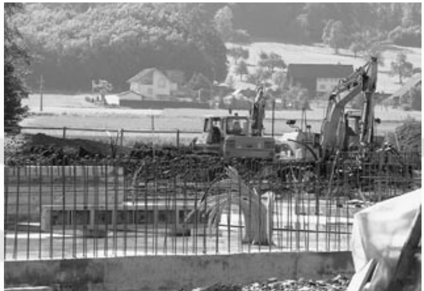
Aktueller Stand beim Sportpark-Bau.
