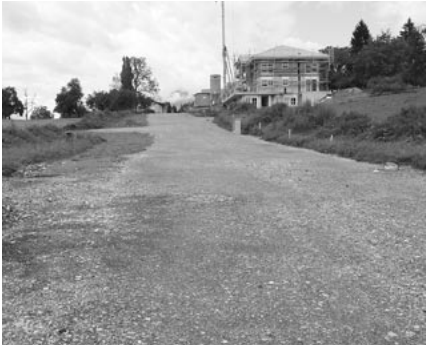
Rohbau der Bönerstrasse in Richtung Popers.
