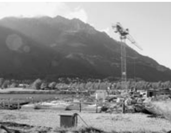
Die Bauarbeiten beim Sportpark schreiten zügig voran.
