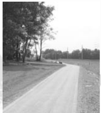
Der neue Fuss- und Radweg entlang der ÖBB-Linie ist ca. 900 Meter lang und erfreut sich reger Benutzung.
