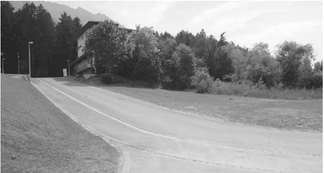
Blick auf die neu gebaute Einfahrtsstrasse ins Baulandumlegungsgebiet «In den Teilen», Schaanwald in Richtung Vorarlbergerstrasse.
