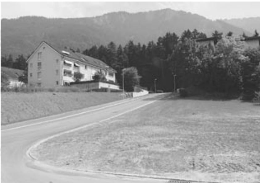
Erschliessungsstrasse des Bauland-Umlegungsgebietes «In den Teilen», Schaanwald ist fertiggestellt.
