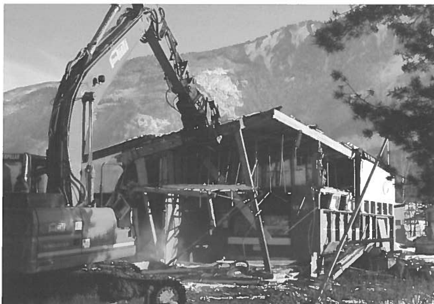
Mit grossen Bagger am Werk.
