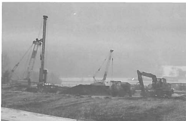
Die Arbeiten am Sportpark schreiten zügig voran.
