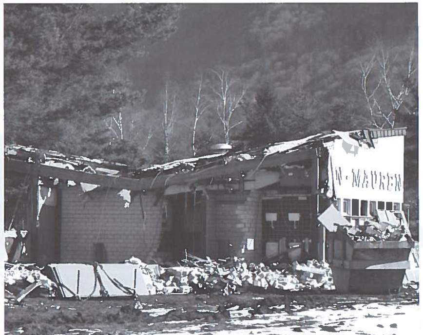
Abbruch des Kioskbereichs.
