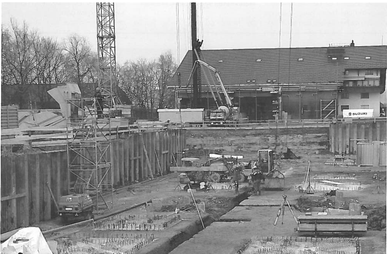
Die Bodenplatte wird gelegt.
