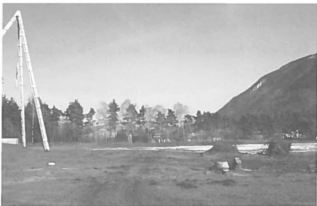
Beginn der Tiefbauarbeiten.
