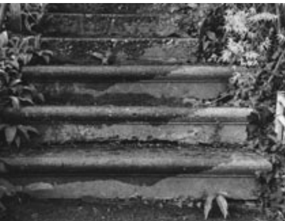
«Gulerstäga»: Die ersten drei Tritte wurden seinerzeit in «Luxusausführung» erstellt.
