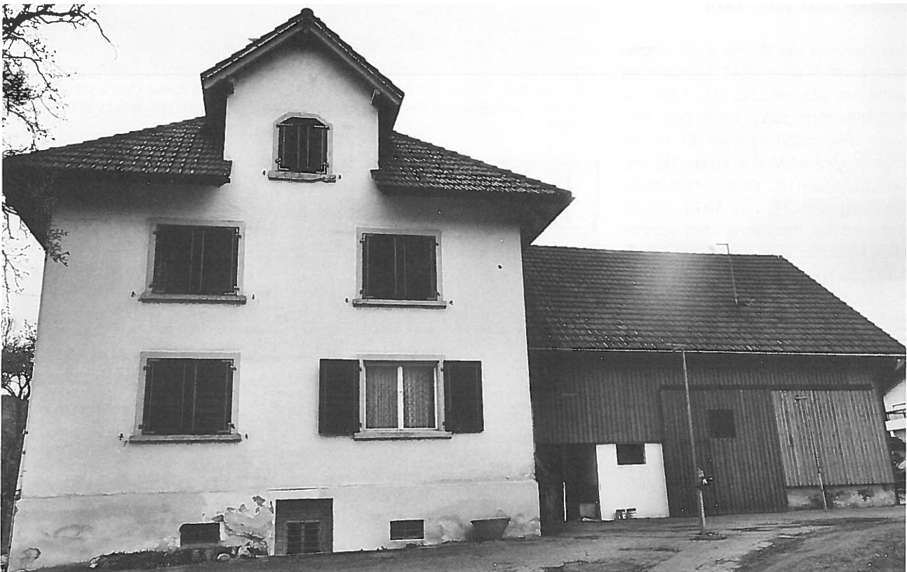
Karl Matt, 1881–1965, erbaute im Jahre 1920 im Böner (Britschen) ein schönes und markantes Gebäude samt Scheune, welches die Hs. Nr. 179 erhielt. Die Pläne stammten von Josef Malin, Stuckkateur, Binza. Die Aufnahme wurde im Mai 2003 gemacht. Das Haus wurde kurz darauf abgebrochen.
