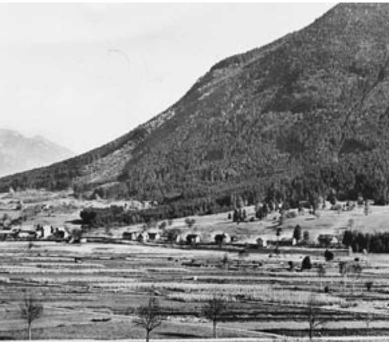
Das Maurer Riet vor der Rheinüberschwemmung im Jahre 1927. Man sieht noch zahlreiche Tuarbahüsle.
