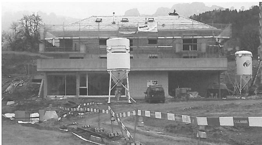
Haus und Fahrradshop von Martin Matt *1972 im Rohbau. Hier stand 83 Jahre lang das von Karl Matt erbaute Haus samt Stall.
