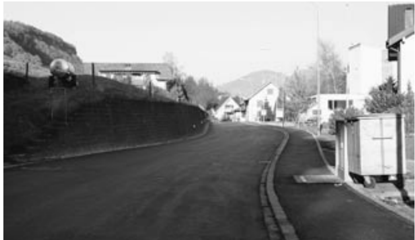
Blick auf die sanierte und neu gestaltete Binzastrasse nach den Bauarbeiten im November 2003.
