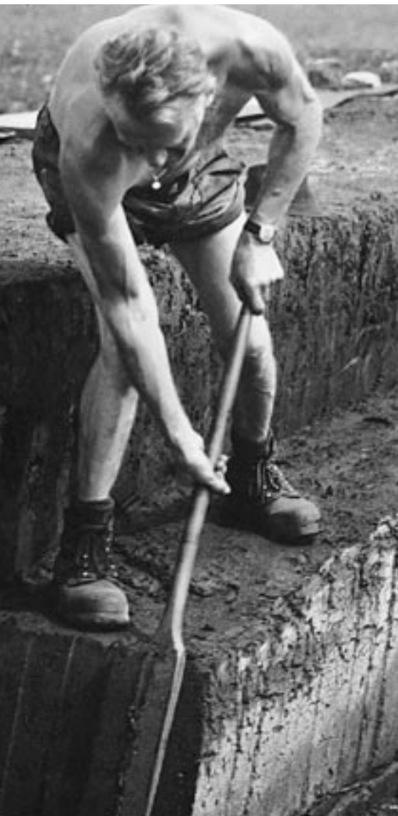
Die hier gestochenen Tuarba sind zwischen 50 und 55 cm lang und wogen rund 3 kg. Es war eine mühsame Arbeit. Der verwendete Stechspaten bestand aus Hartholz und hatte vorne ein scharf geschliffenes Metallstück mit dem der Torf aus der Erde getrennt wurde.
