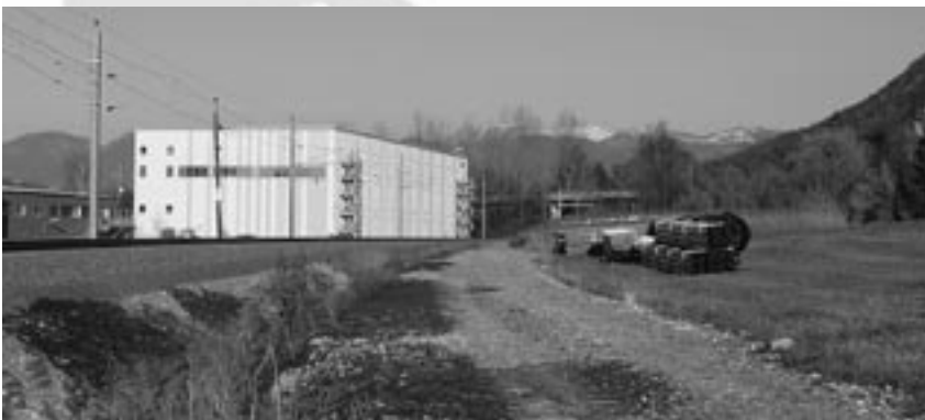
Mit einer Länge von 450 m wird der Fuss- und Radweg in Zukunft den Bahnweg und die Sportfeldstrasse miteinander verbinden.
