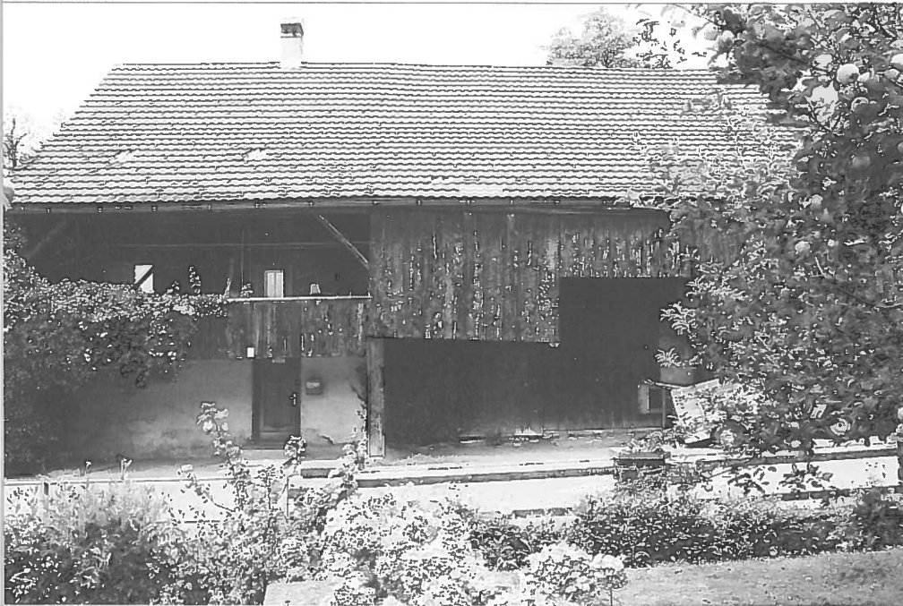
Das Urschile-Huus zählt zu den ältesten Häusern in Mauren. Es wurde anno 1845 von Johann Meier erbaut. Wir finden am Haus noch die letzte «Zinkala» und das letzte «Löbele» in Mauren.
