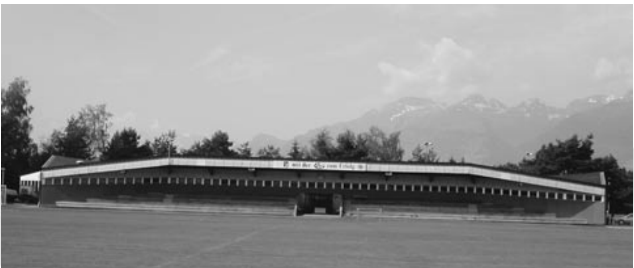
Das Hauptgebäude mit Tribüne muss abgerissen und ersetzt werden. Zu gross sind die Schäden durch die ständigen Bodenverschiebungen.
