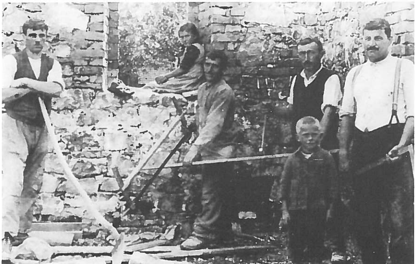
Bauarbeiten, Stallgebäude beim Hälm (Joseph Bühler). Links: Pepi Batliner (Asper-Pepi) 1903–1990. Mitte: 2 Fremdarbeiter. Ganz rechts: Hermann Matt (Tele-Hermann) und dessen Kinder Rosa und Adrian.
