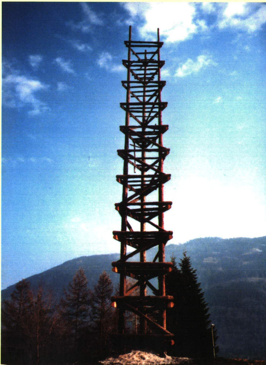
So sah der Werthner Funken 2002 nach dem Abbrennen am Montagmorgen aus. Die drei Latten stehen noch. Nur die Asche verrät, dass hier ein Funken abgebrannt worden .
