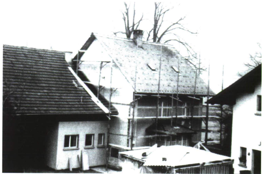
Renovation von Hs. Nr.69 des Humbert Meier im Werth im Jahre 1985.
