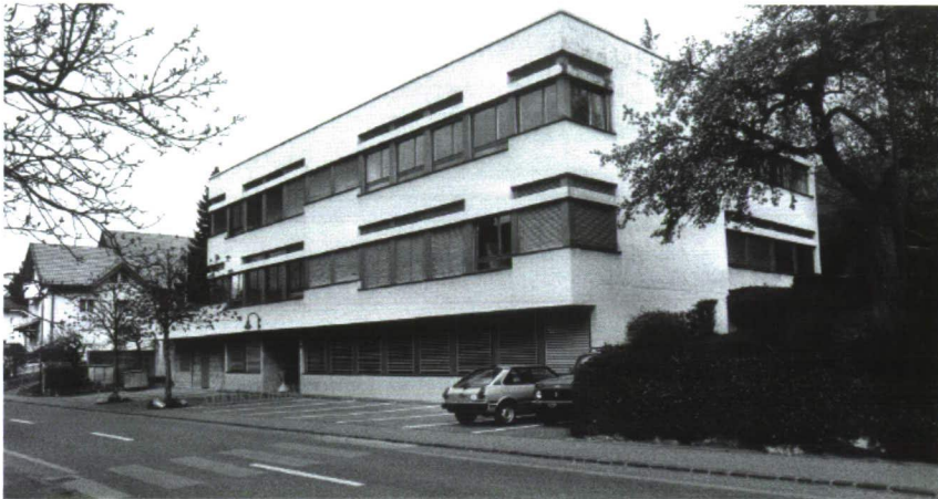
Hier sehen wir das Vereinshaus vor dem Dachaufbau in den 1990er-Jahren.
