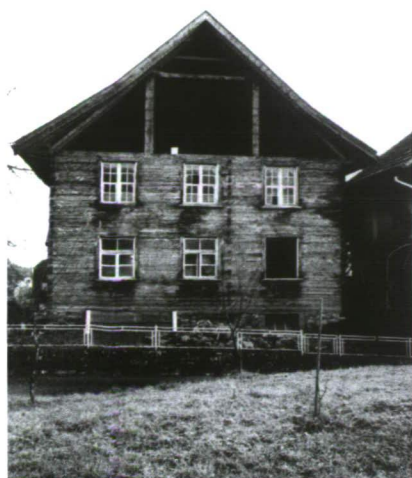
Hs. Nr.66 während der Abbrucharbeiten.
