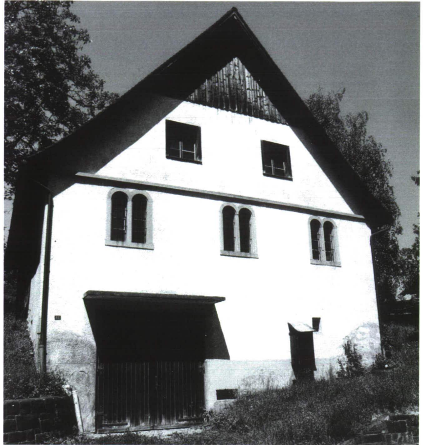
Unsere Aufnahme zeigt den Torkel auf dem Werth, welcher auf eine geschichtsträchtige Vergangenheit zurückblicken kann. Er trägt seit ein paar Jahren die Hs.Nr.62.
