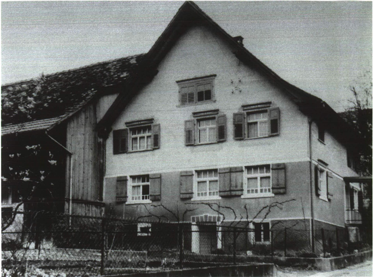
So sah das alte Haus Nr. 30 der «Hansjörg-Oehri's» im Freiendorf vor der gründlichen Renovation anfangs 1990 aus. Links sehen wir noch den Stall und ein Stück des Zwischengebäudes. Der Eingang befand sich – wie heute auch – zur Freiendorfstrasse.
