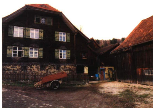
Haus Nr. 107 neu (98 alt), «Jäger-Hus», Rennhofstrasse.
