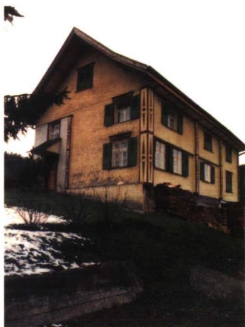
Haus Nr. 40, Ida Kieber, Steinbösch.
