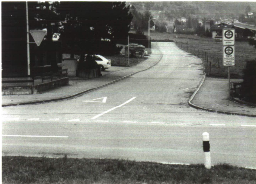
Gampeluzstrasse Mauren: Auch hier erteilt die Regierung keine Subvention. Eine billige, kostengünstige Sanierungsvariante entspricht nicht der Vorstellung der Regierung. Sie widerspricht dabei ihrem eigenen Grundsatz der Sparsamkeit.
