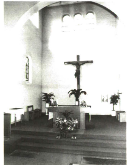
Blick auf den Altarraum vor der Renovation.
