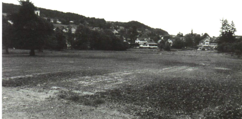
Die Aufschüttung im Rahmen der Weiherringgestaltung im Zentrum der Gemeinde hat bereits begonnen. Hier geht es um die Zielsetzung ein möglichst niveaugleiches Terrain zu erreichen.
