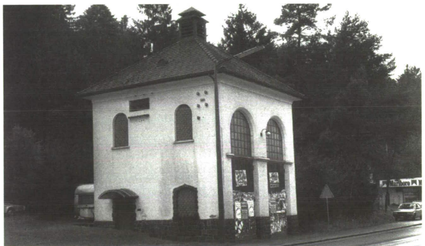
Die 1941 errichtete Umspannstation Schaanwald wurde als Industriedenkmal unter Schutz gestellt.
