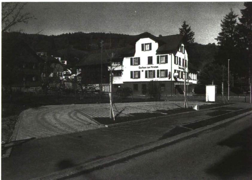
Unser Bild zeigt die Neuanlage der Parkplätze bei der Telefonzentrale.
