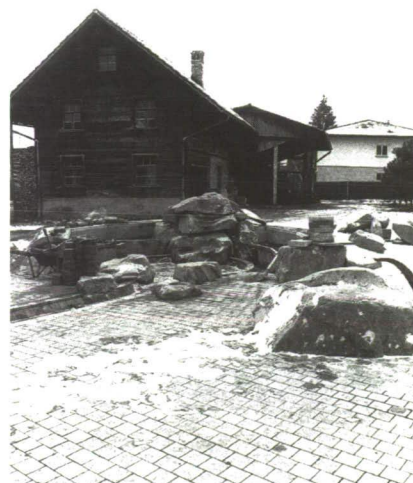
Blick in die noch nicht ganz fertiggestellte Brunnenanlage.
