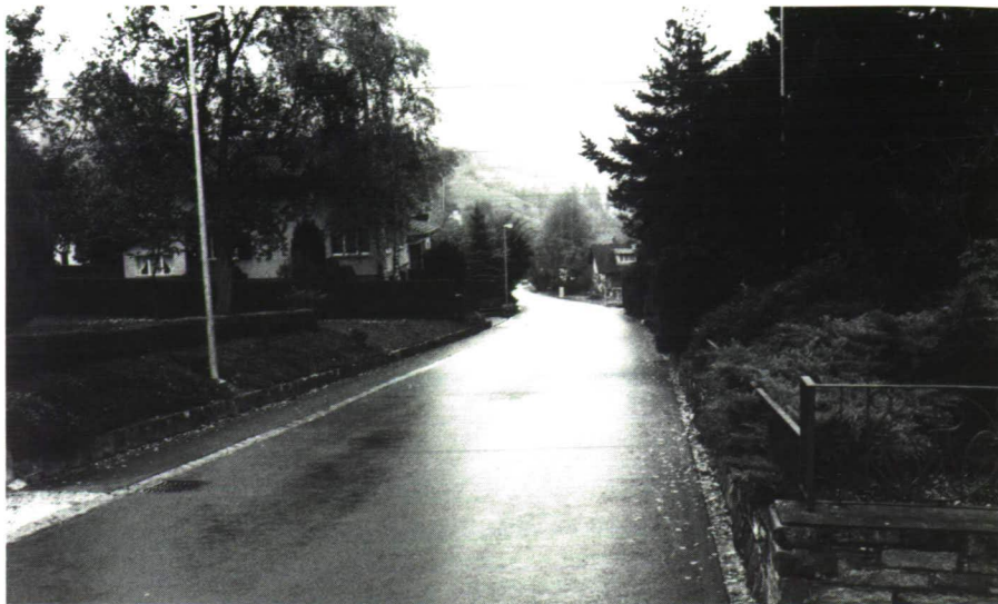
Das fertiggestellte dritte Teilstück der Fürst-Franz-Josef-Strasse, das 250 Meter lang, mit einer Fahrbahnbreite von 5 Metern und einem Trottoir von 1 Meter ausgestattet ist. Die Gemeindenkosten für den Ausbau beliefen sich auf rund 365'000 Franken.
