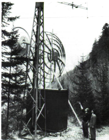
Der Betreiber der Gemeinschaftsantennenanlage muss beträchtliche Mittel für die Verbesserung der Infrastruktur einsetzen. Hier sehen wir Vorsteher Johannes Kaiser mit Bruno Matt bei der Besichtigung der Kopfstation am Maurerberg.
