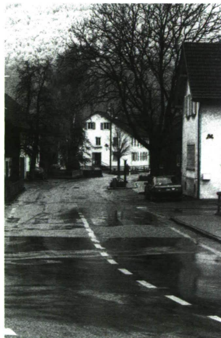
Eine halbe Million Schweizerfranken sind im Strassenbauprogramm 1992 der Regierung zur Sanierung der Landstrasse Mauren (Teilabschnitt Britschenstrasse bis zum Café Matt) vorgesehen. Unsere Aufnahme zeigt das zu sanierende Strassenstück mit Blick vom Café Matt in Richtung Post/Bürgerheim.
