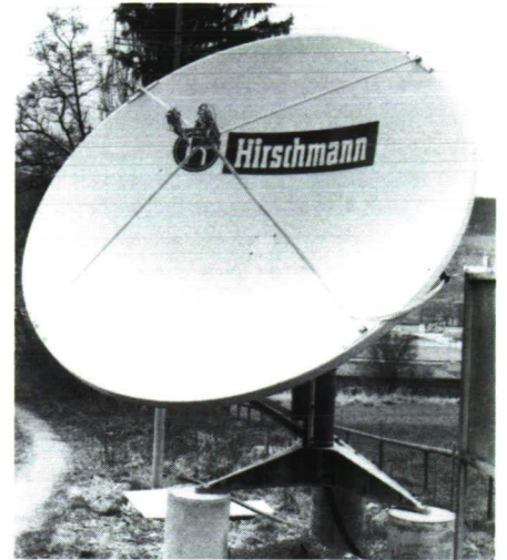
Von der Kopfstation-Empfangsanlage werden die Programme via Koaxkabel an die Signalaufbereitungsanlage zur Voralbergerstrasse (Nähe Waldhof) geführt. Neben der Aufbereitung der Signale werden an diesem Ort die Satellitenprogramme empfangen, aufbereitet und ins Netz eingespeist.
