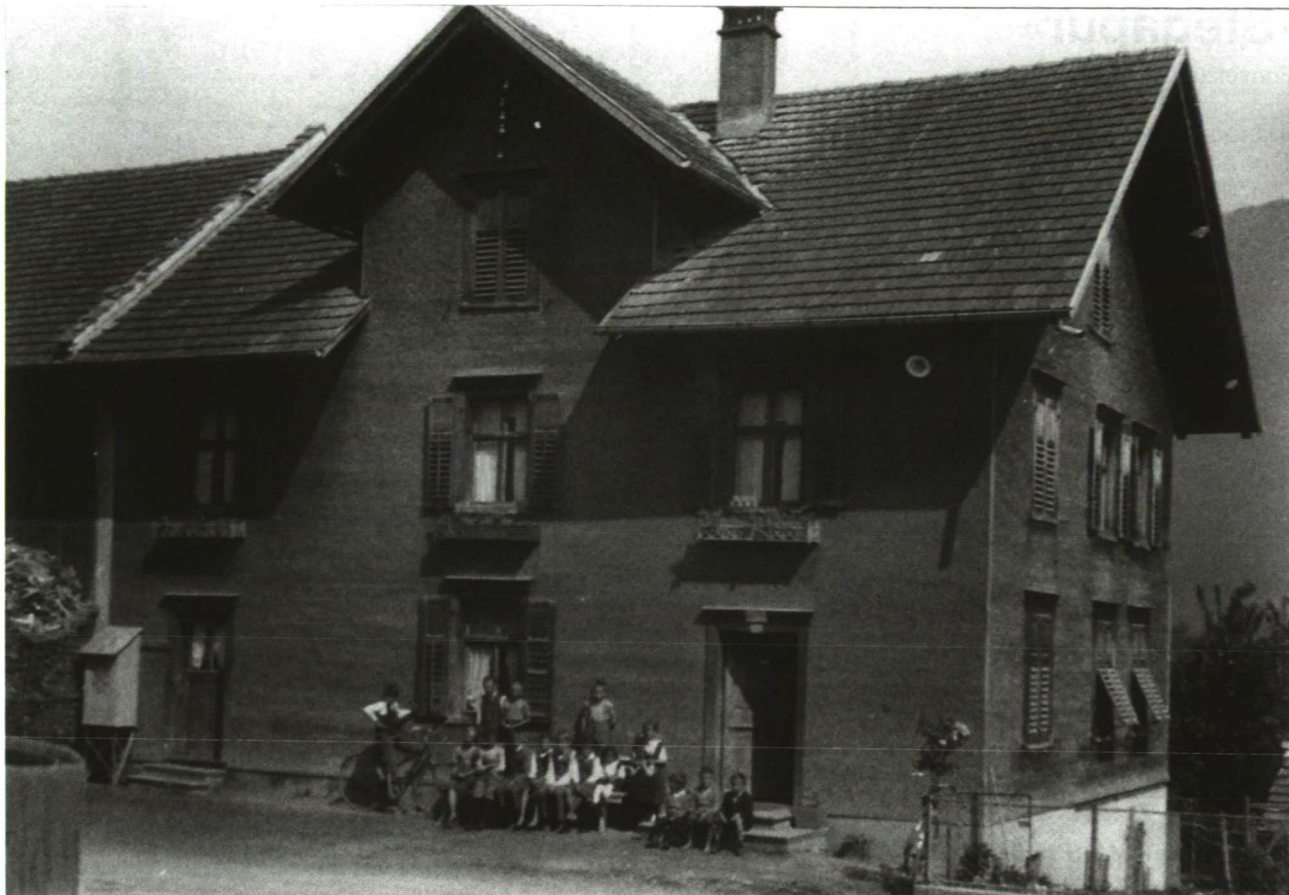
Haus Nr. 45 der «Stegapur-Ritters» in der Rosenstrasse / Eingang zum Steinböös. So sah das Haus nach dem Wiederaufbau (Brand 1916) aus.
