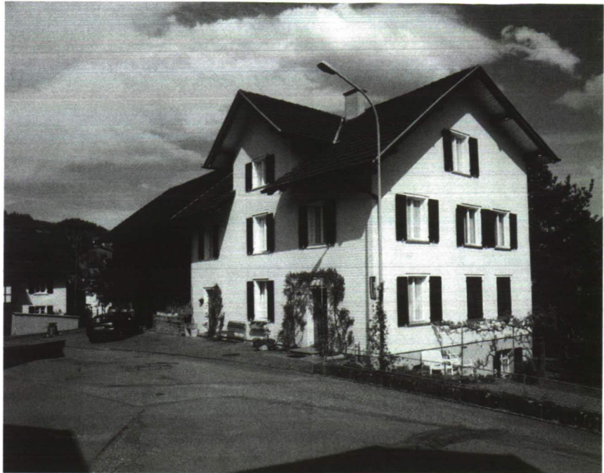
Hier sehen wir heute das «Stegapura-Huus» Hugo Ritter im Steinböös nach der Renovation. Das Haus wurde nach dem Brand im Jahre 1916 von Markus Ritter auf dem gleichen Platz samt Scheune wieder aufgebaut. Das Haus wurde aussen und innen renoviert, ohne dabei den Charakter und Stil des Vorgängerhauses zu verlieren.
