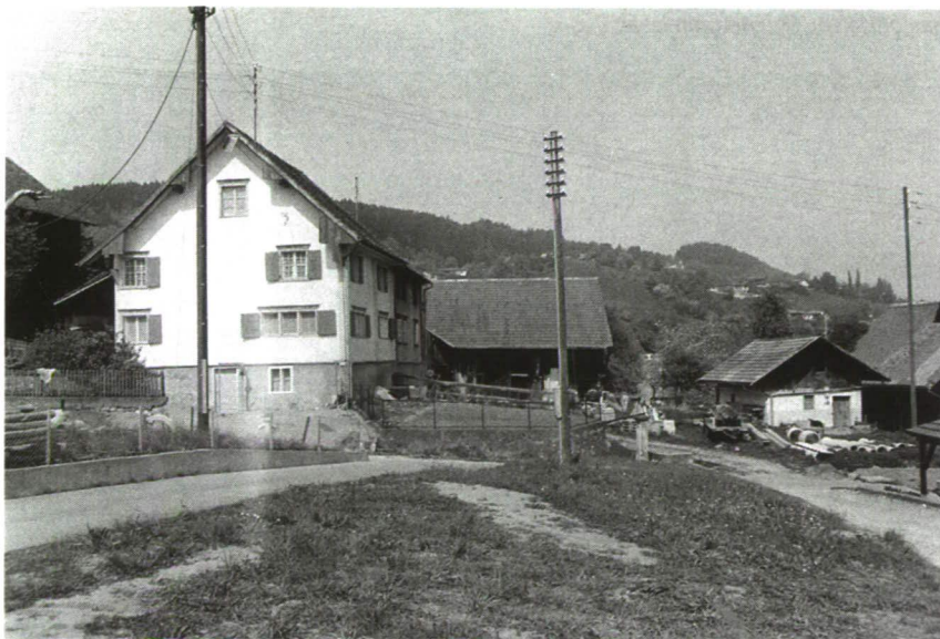
Vorne sehen wir das Haus Nr. 42 («Kaiseralois») vor dem Abbruch 1974; hinten den Stall von Josef Bühler und unten den kleinen Stall, der ebenfalls zum Haus Nr. 43 der Bühlers gehört hatte. Alle Liegenschaften wurden abgebrochen. Hier führt heute eine neue Strasse vorbei, Felbenweg genannt, der das hintere Gebiet erschliesst.
