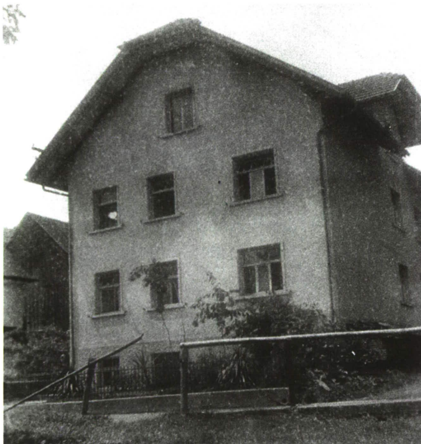
Hier sehen wir das alte Haus Nr. 50 in der Rosenstrasse in Mauren vor dem Brand am 20. Juli 1934. Das Haus wurde 1934 von Emil Ritter (1878-1948) zusammen mit seinem Sohn Bertram wieder aufgebaut. Emil wurde im Volksmund «dr Wiiss (Weisse)-Stegapuur» genannt. Er war von Beruf Schreiner und Sargmacher in Mauren. Das Haus Nr. 50 wurde dann durch Rudolf Jäger, Schaanwald, der als Mittelsmann auftrat, von Emil Jäger Nr. 50 gekauft. Der Volksmund nennt ihn auch «dr Wiiss Schuamacher» (*1904-1999). Sein Sohn Benno Jäger liess das Anwesen 1992 komplett renovieren und zu einem fast majestätischen Anwesen umbauen.
