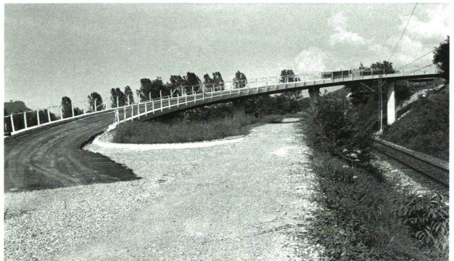
Mit der Realisierung der dritten und letzten Etappe, der OeBB-Brücke Nord, ist die Zielsetzung zur Erlangung von freien Bahnübergängen erreicht worden. Damit wurde ein wesentlicher Beitrag zur Verkehrsverbesserung geleistet. Land, Gemeinde und OeBB waren beidiesem Projekt Partner.
