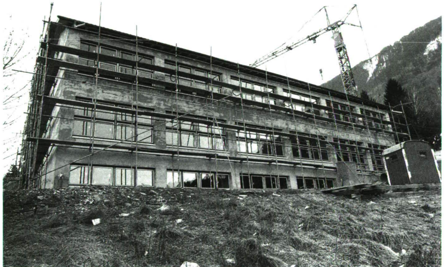
Schule Schaanwald während der Bauphase.
