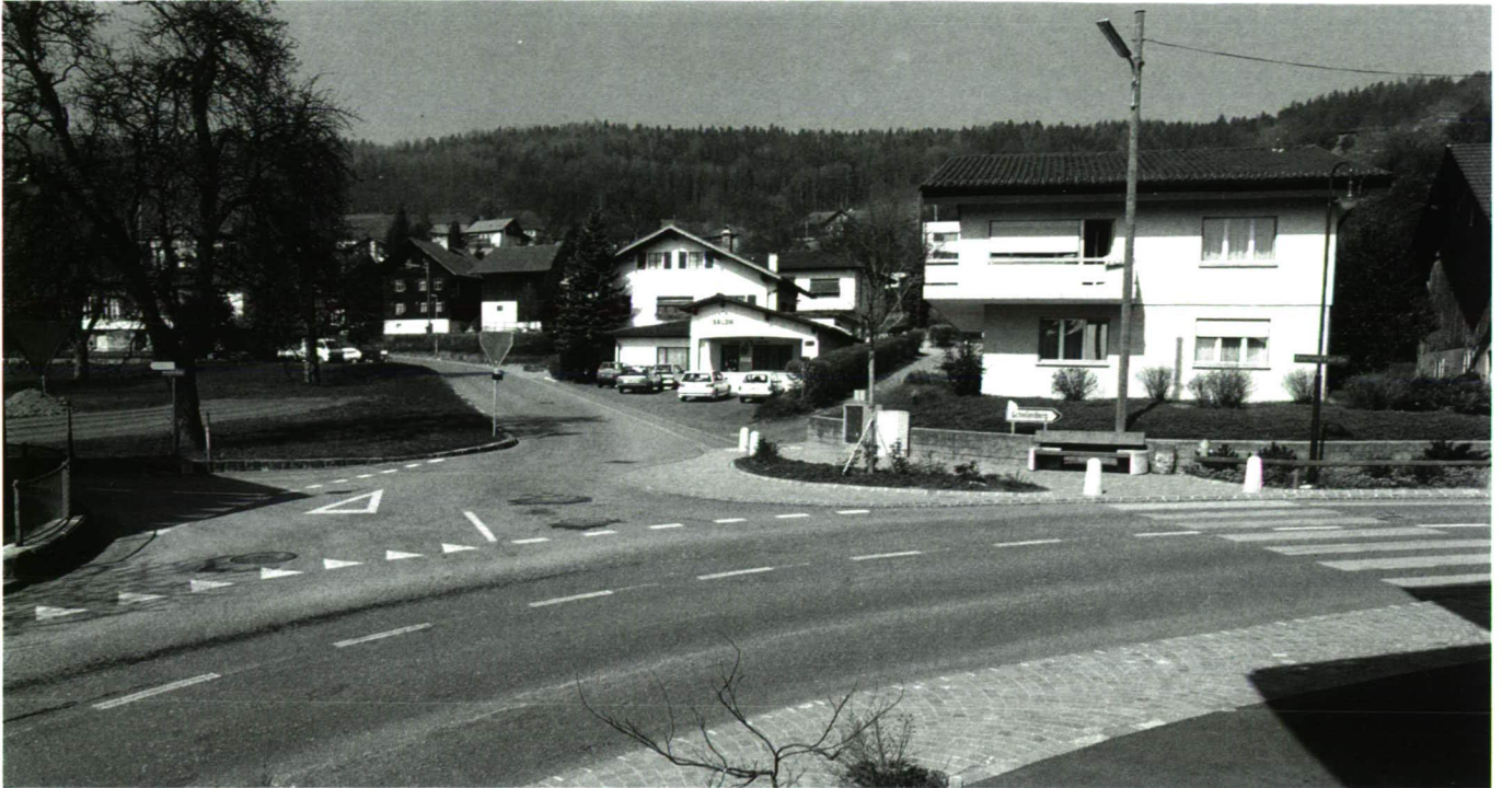
Im Zuge des Ausbauprojektes Lutzfeld sind im Kreuzungsbereich Fürst-Franz-Josef-Strasse und der Peter- und Paulstrasse verkehrsberuhigende Massnahmen gesetzt worden. Mit der halbinselförmigen Strassenraumgestaltung (Bepflanzung, Sitzplatz, Trottoir) wird zudem eine Verschönerung des Ortsbildes erreicht.
