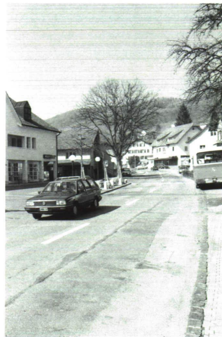
Aufgrund des schlechten Zustandes der Strasse im Bereich des Teilstücks «Freihof-Café Matt» einerseits und der Notwendigkeit der Sanierung andererseits ist der Ausbau dieser Teilstrecke dringend, notwendig. Für 1991 ist der entsprechende Ausbau ab Britschenstrasse vorgesehen.
