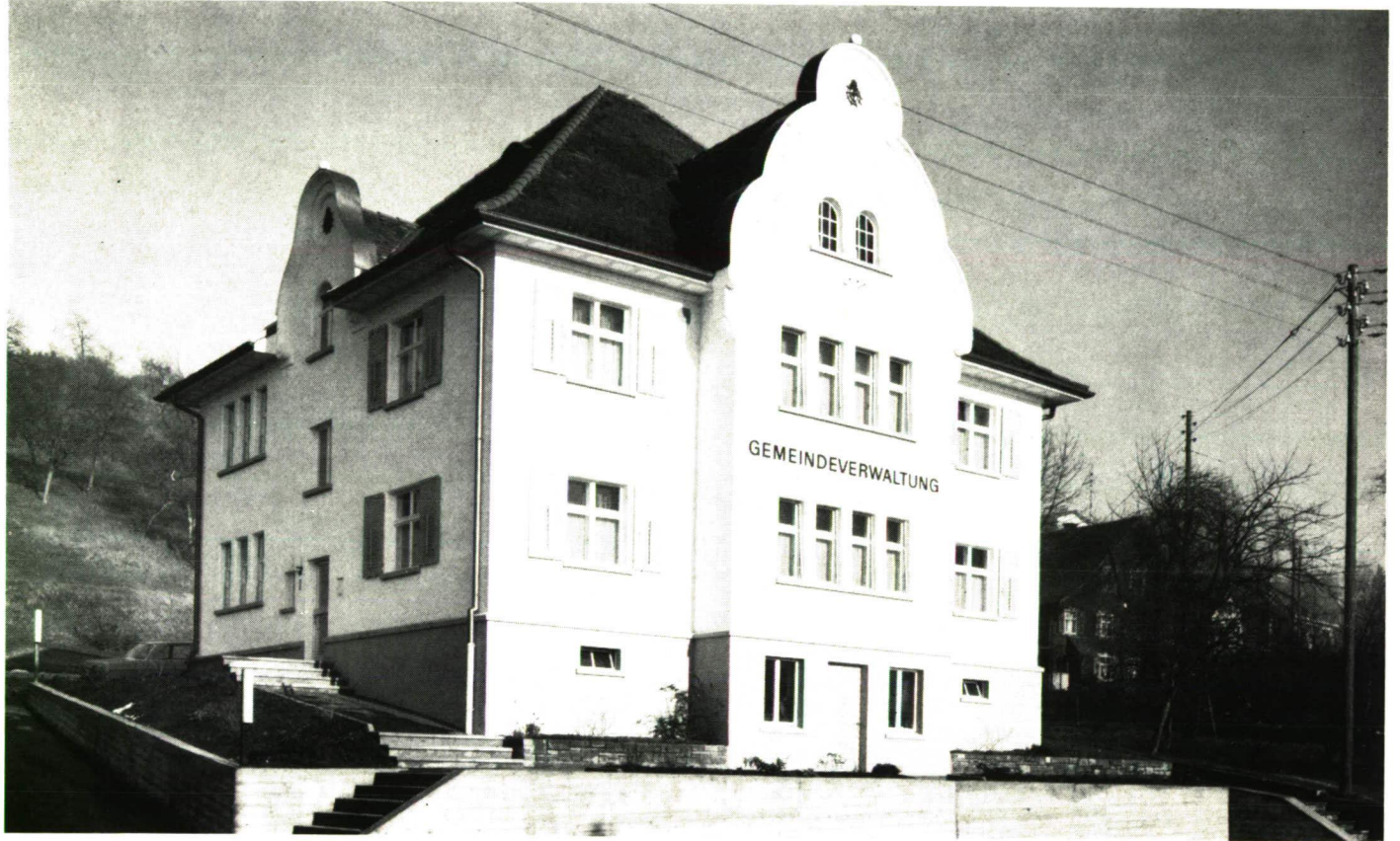
Neues Gemeindeverwaltungsgebäude Mauren
